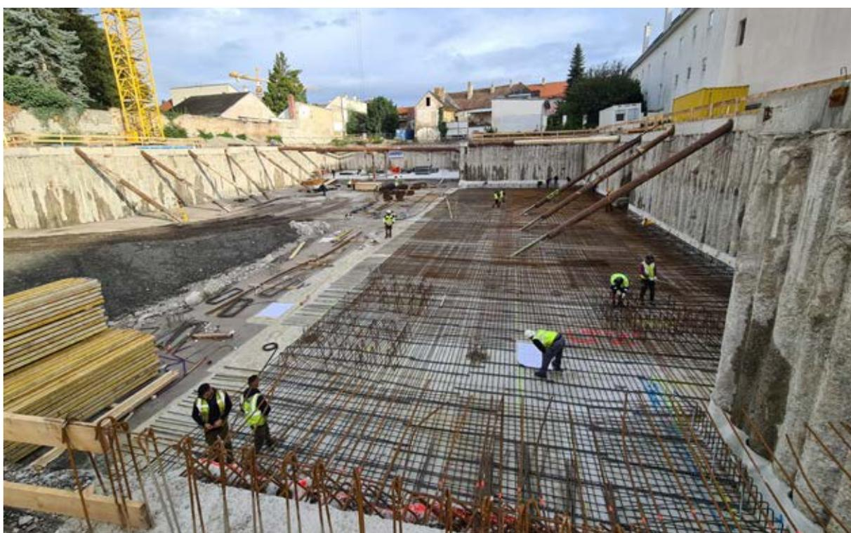
Bild 3: Bauteil 1+2: überschnittene Pfahlwand
