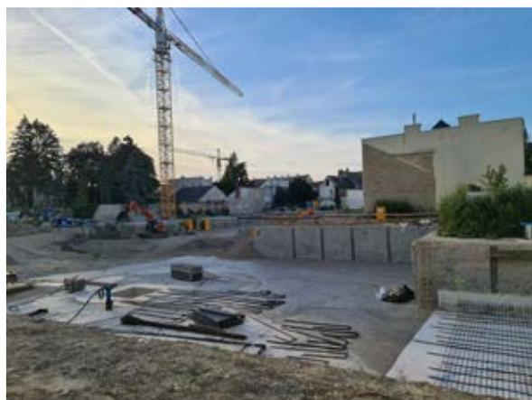
Bild 4: Bauteil 3: MIP-Verbauwand
