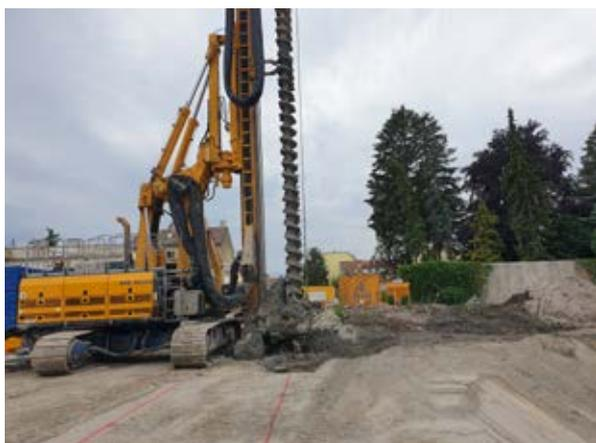
Bild 2: BAUER RG 25 s – Herstellung MIP-Verbauwand
