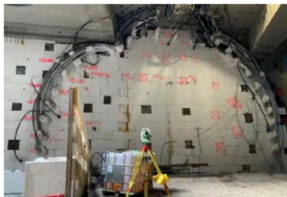
Abbildung 9: Soleverteilergruppe und Ansicht Anschlagwand T2
