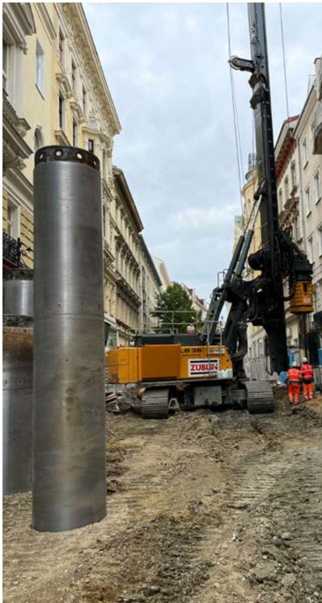
Abb. 8: Ausführung der BPF-Arbeiten in der Baustelleneinrichtung Lindengasse
