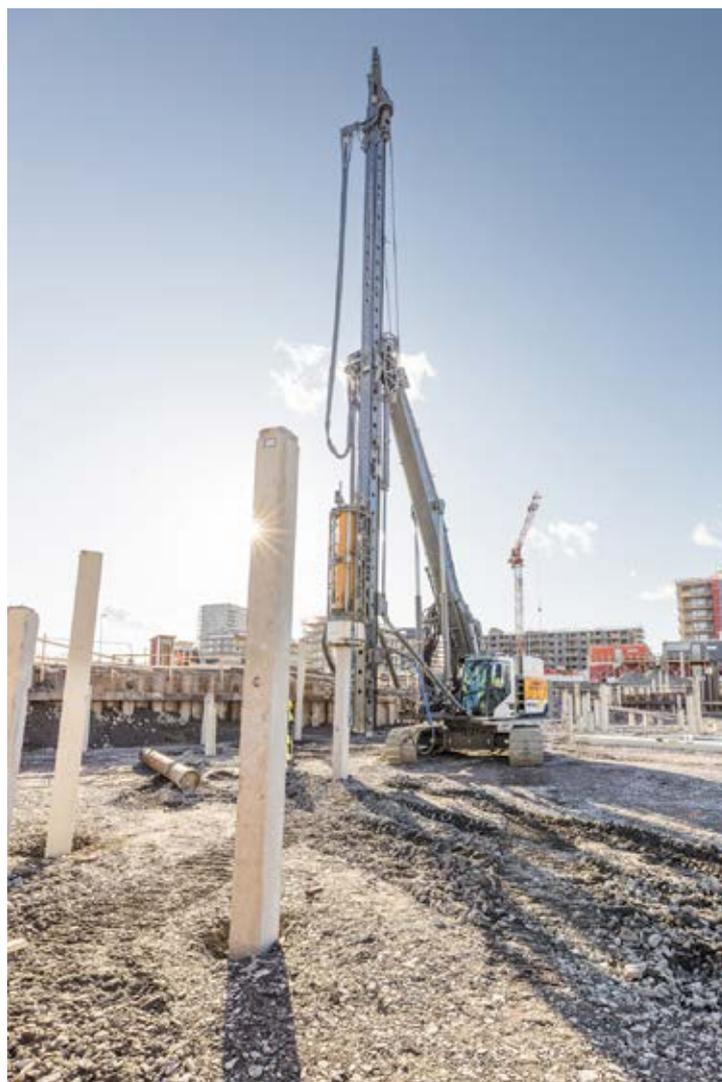
Das LRH 100.1 unplugged rammt im schwedischen Karlstad mit dem Hammer H 6 Pfähle in den Boden.
