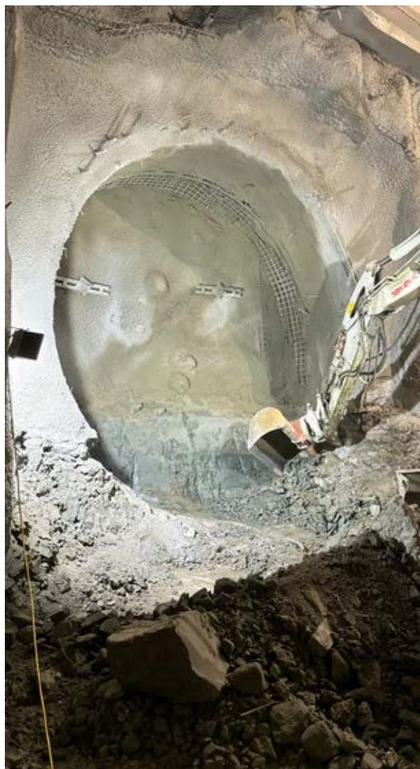
Abb 7: Herstellung des Pilotstollens
