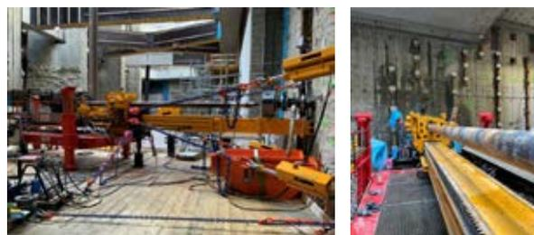
Abbildung 4: Bohrlafette auf Unterbau + Abspannung
