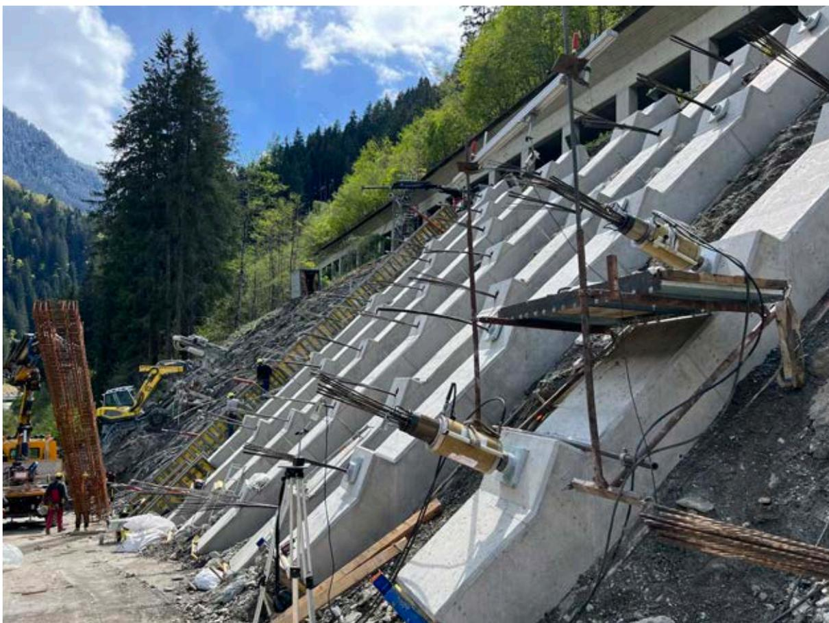
Spannkonzert mit parallel eingesetzter Spanneinrichtung [2]
