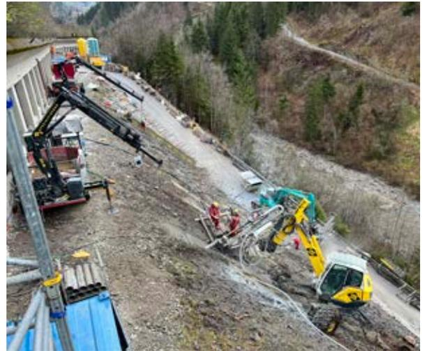
Herstellung der Bohrlöcher der Daueranker mit Schreitbagger und Anbohlafette [2]
