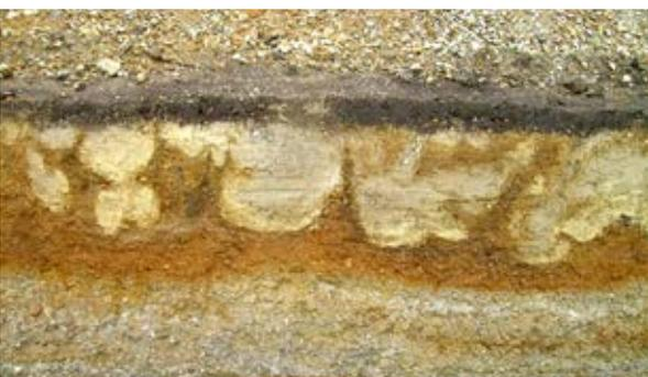
Geologie eines Rohrgrabens
