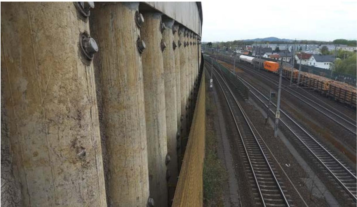
Abb. 2: Ankerwand angrenzend an das Schienennetz
