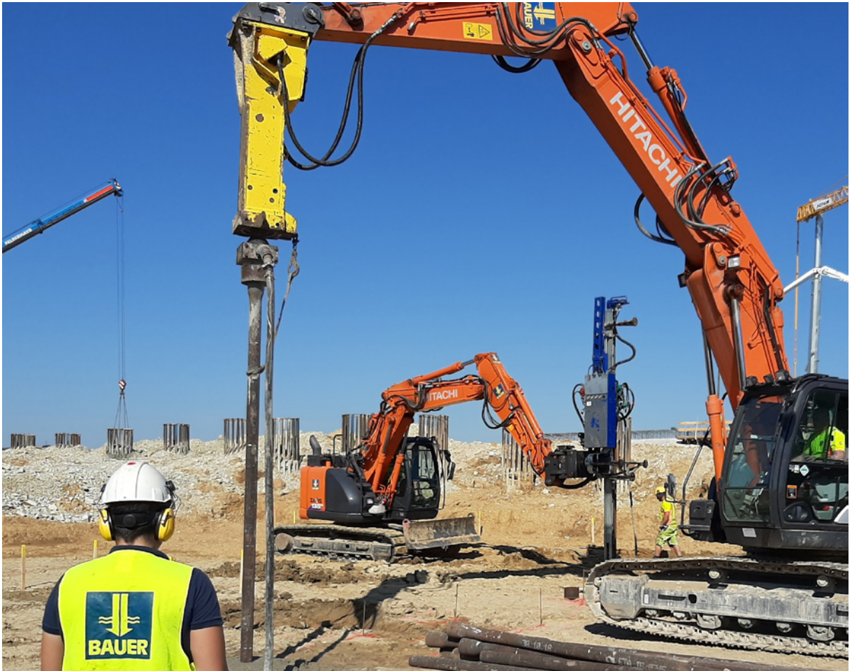
Herstellung duktiler Pfähle für statische Probelastung
