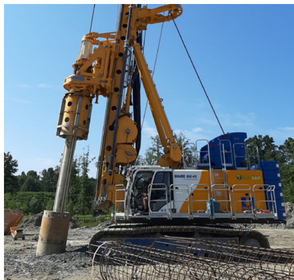
BAUER BG 45 bei der Herstellung von Schrägpfählen
