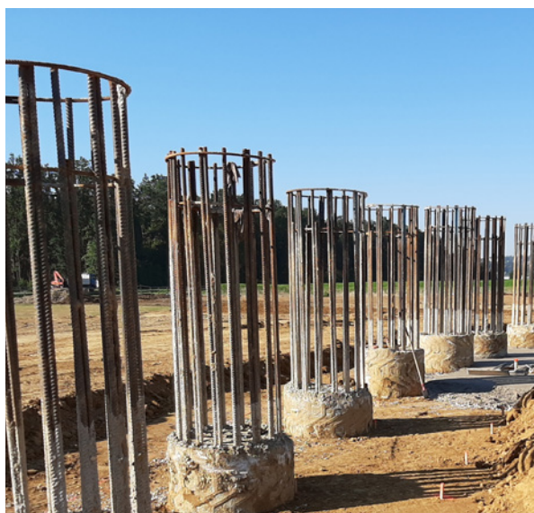
Fertiggestellte Pfähle für eine integrale Brücke
